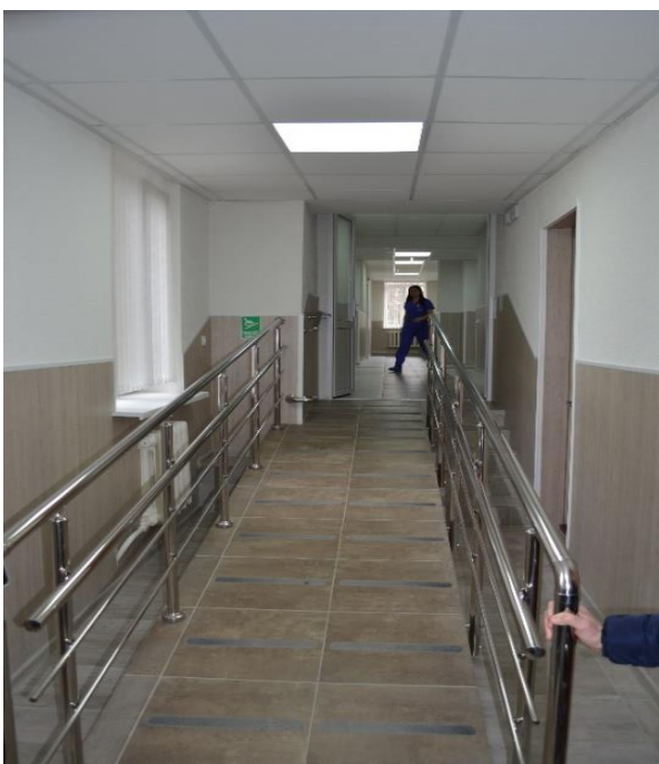
Foto 5, Rampa de acces etajul 1
