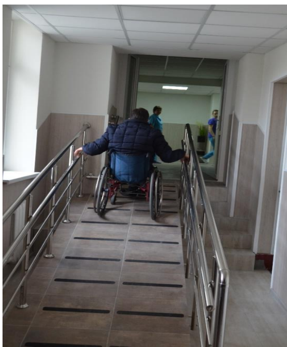
Foto 6, Rampa de acces etajul 2
