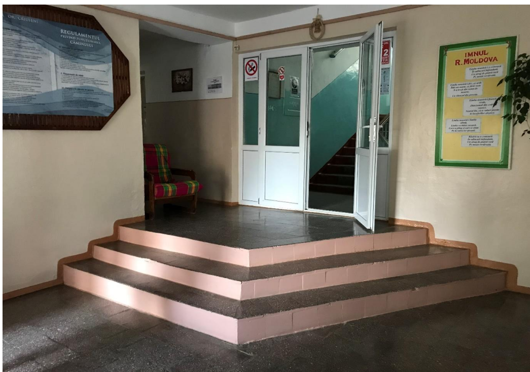
Treptele din interiorul căminului
